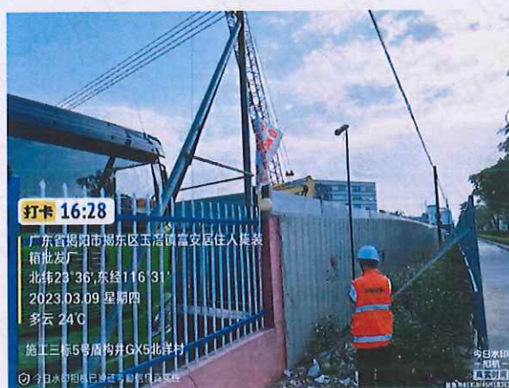
施工 3 标 5 号盾构井南侧厂界外 1 米 3#
