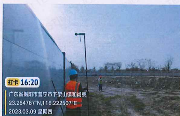
施工区 PN18 顶管井北侧厂界外 1 米 1#
