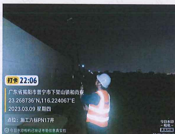
施工区 PN17 顶管井东侧厂界外 1 米 1#
