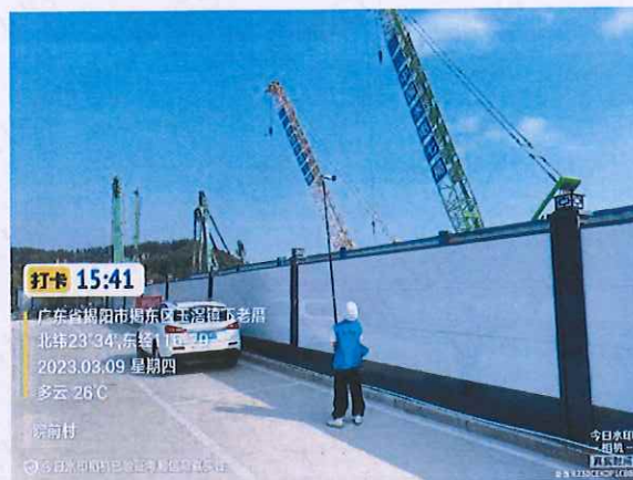
施工 2 标 8 号盾构井东侧厂界外 1 米 2#
