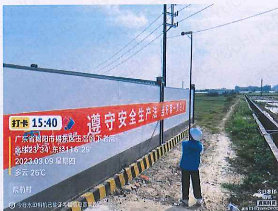
施工 2 标 8 号盾构井南侧厂界外 1 米 1#
