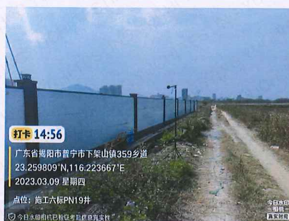
施工区 PN19 顶管井东侧厂界外 1 米 2#
