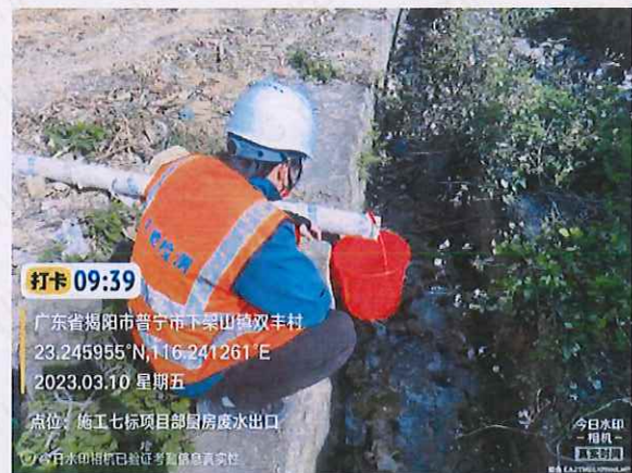
施工七标项目部厨房生活污水
